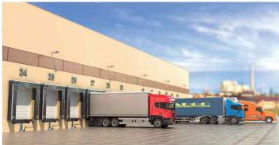
Figura 2.2. Zonas de carga y descarga integradas. Puertas con cierre de abrigo.
