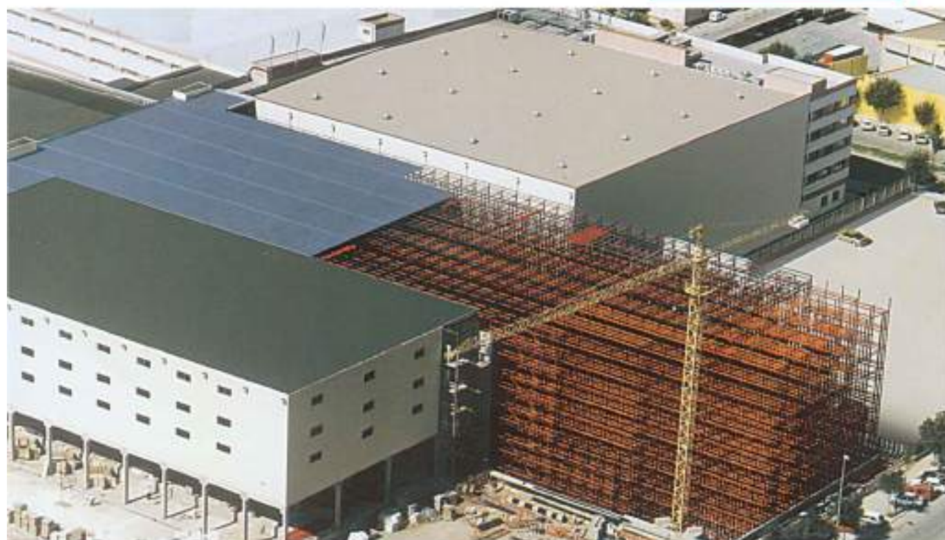
Figura 4.8. Almacenes autoportantes. Cortesía de Mecalux.
