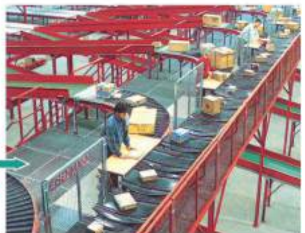
Cinta transportadora con banda de goma.
