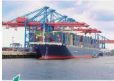
Estiba de contenedores con grúas instaladas en el puerto.
