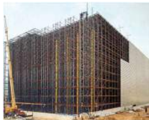
Almacén autoportante en construcción. Cortesía de Mecalux.
