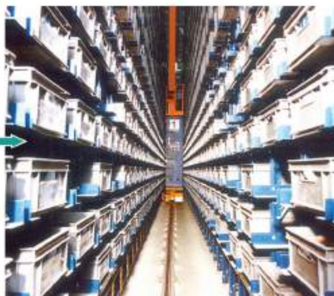
Figura 4.2. Almacenaje en AAC sistema «producto hacia el operario» Cortesía de Mecalux.
